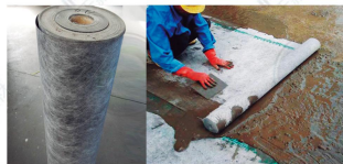
■ 聚乙烯丙纶防水卷材-施工
