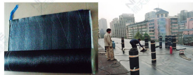
■ SBS防水卷材-施工
